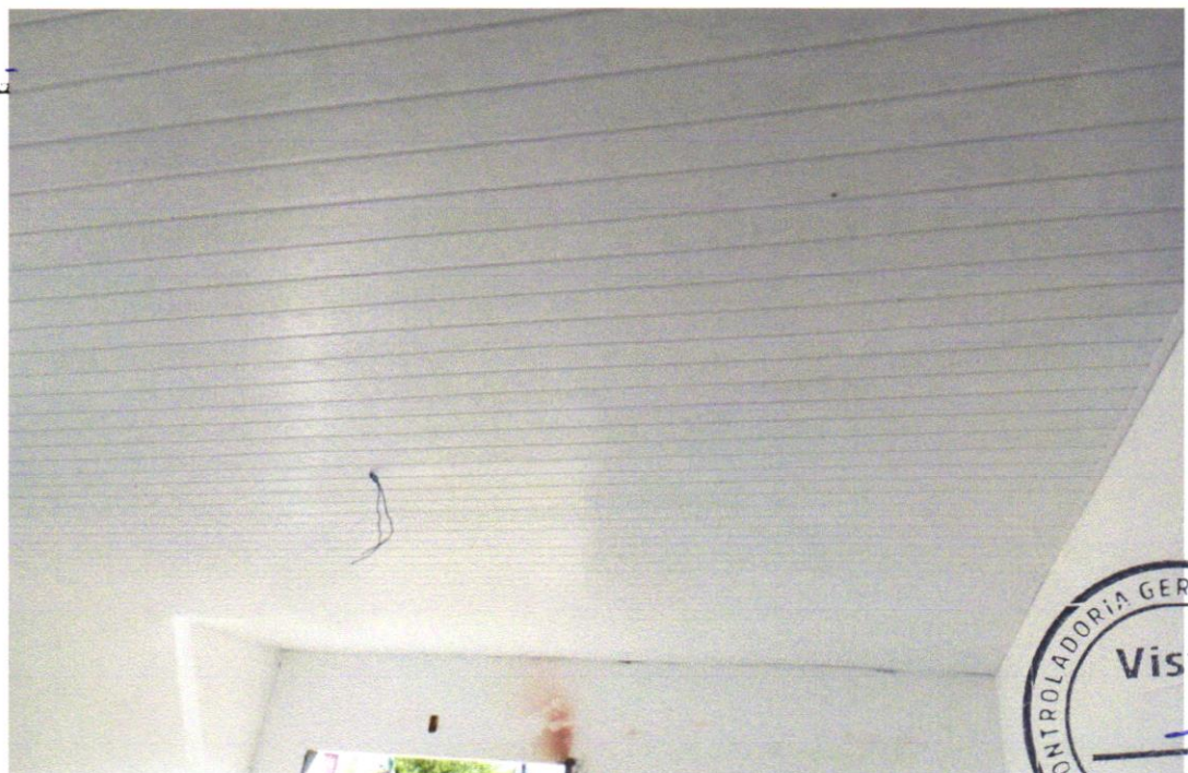
FOTO 8 – Forro de pvc, em régua de 10 ou 20 cm, aplicado, inclusive estrutura para fixação (perfis em PVC) marca Araforros ou similar, instalado - Rev 06_10/2021
