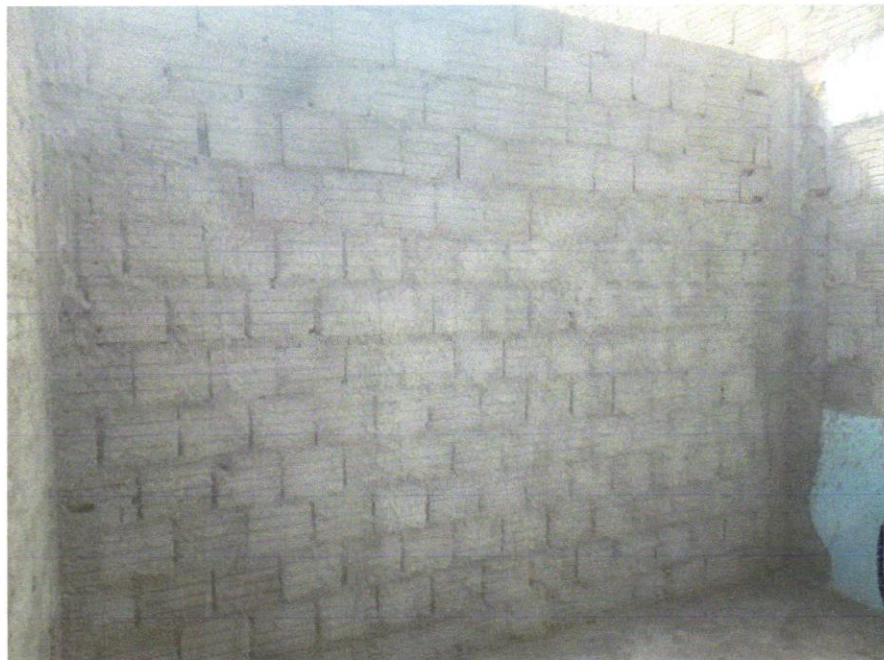
FOTO 4 - CHAPISCO APLICADO EM ALVENARIA (COM PRESENÇA DE VÃOS) E ESTRUTURAS DE CONCRETO DE FACHADA, COM EQUIPAMENTO DE PROJEÇÃO. ARGAMASSA TRAÇO 1:3 COM PREPARO EM BETONEIRA 400 L. AF_06/2014
