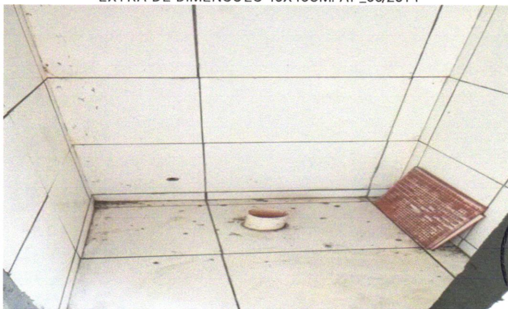
Foto 22 – REVESTIMENTO CERÂMICO PARA PAREDES INTERNAS COM PLACAS TIPO ESMALTADA EXTRA DE DIMENSÕES 33X45CM APLICADAS EM AMBIENTES DE ÁREA MAIOR QUE 5M2 A MEIA ALTURA DAS PAREDES. AF_06/2014
