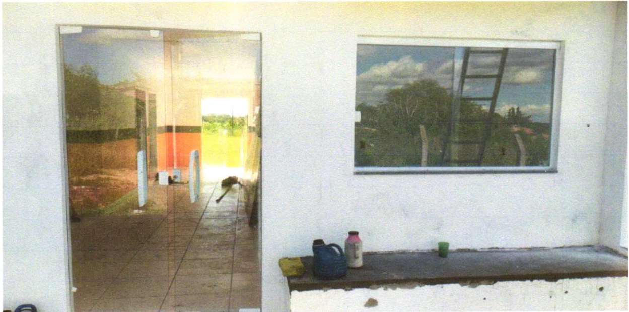
FOTO 5 – Porta em vidro temperado 10mm, incolor, inclusive ferragens de fixação e instalação, exclusive puxador - Rev 01_10/2021
