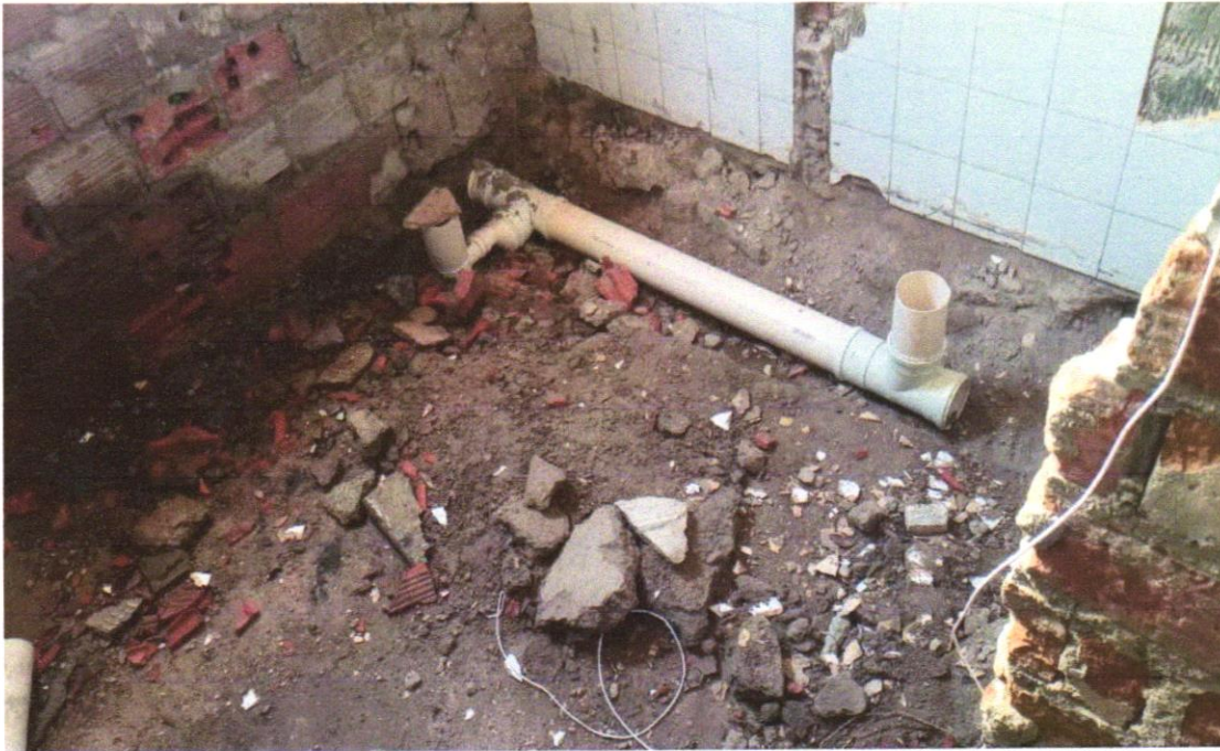
FOTO 19 – TUBO DE PVC BRANCO PARA REDE COLETORA DE ESGOTO CONDOMINIAL DE PAREDE MACIÇA, DN 100 MM, JUNTA ELÁSTICA - FORNECIMENTO E ASSENTAMENTO. AF_01/2021
