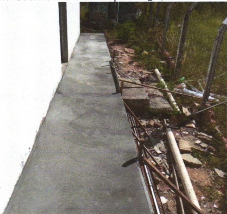
FOTO 32 -EXECUÇÃO DE PASSEIO (CALÇADA) OU PISO DE CONCRETO COM CONCRETO MOLDADO IN LOCO, FEITO EM OBRA, ACABAMENTO CONVENCIONAL, ESPESSURA 8 CM, ARMADO. AF_07/2016
